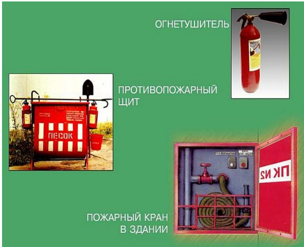
Рисунок 3 - Огнетушитель. Пожарный щит. Пожарный кран.
